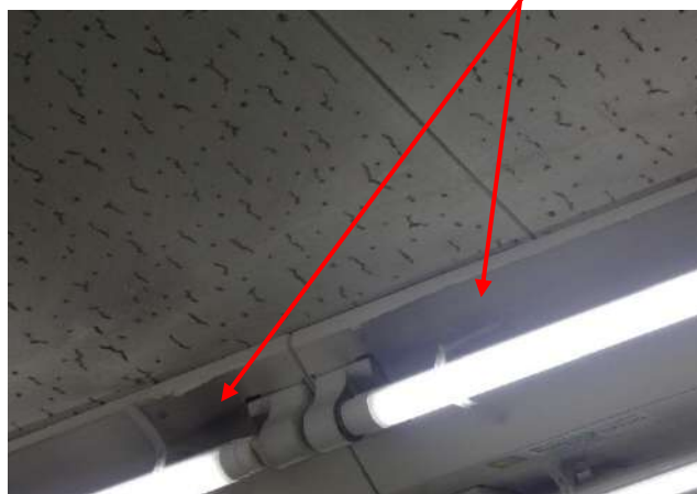
部位を拡大（角度を変えています） 蛍光灯の反射盤に注目。
