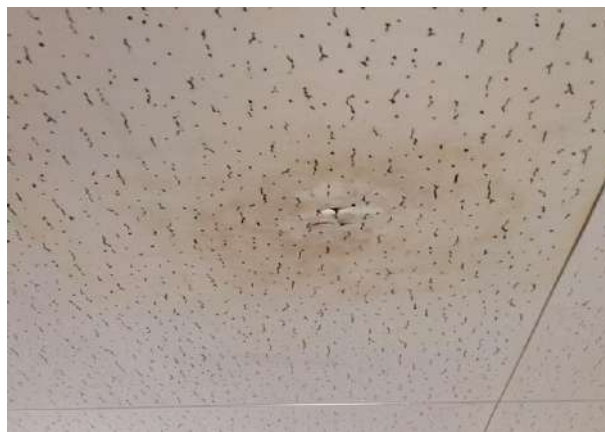
施工後：まだ完全乾燥していないが
